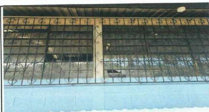
Foto 3: Se observa vidrios quebrados y faltantes en el módulo 1, 2 y 3
