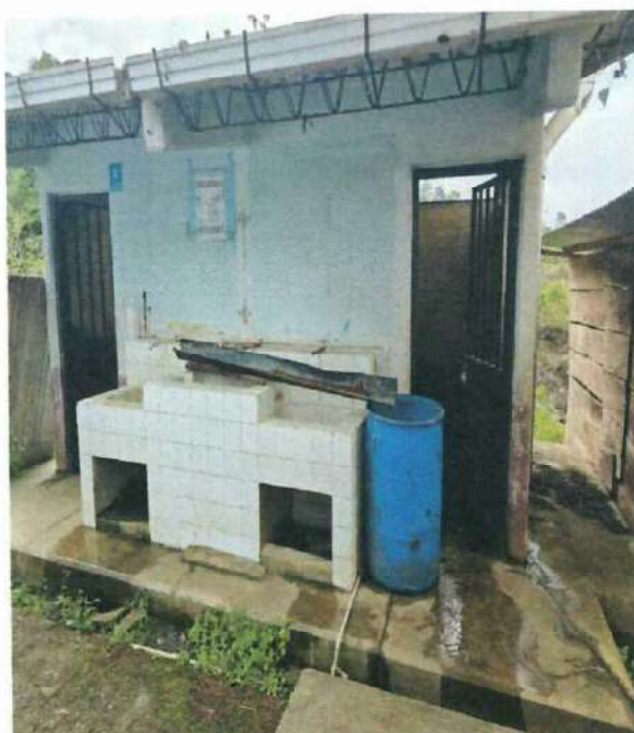
Foto 10: Se observa que faltan chorros en la pila del baño.
