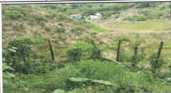
Foto 1: Se observa inseguridad en el centro educativo por la inexistencia de un muro perimetral para el modulo 1, y 2
