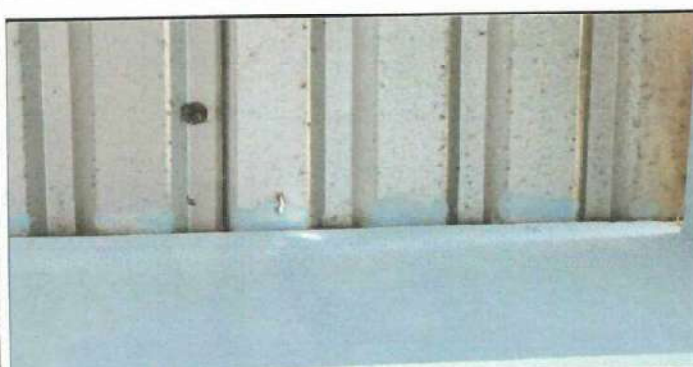
Foto 5: Se observa daño, perforacion y agujero en el techo de los módulos 1 y 2
