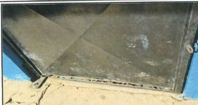
Foto 2: Se observa deterioro en la estructura metálica de la puerta de los modulos No. 1 y 2 incluyendo el porton del establecimiento
